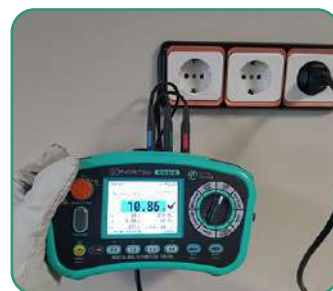
Pomiar impedancji pętli
