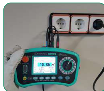
Pomiar impedancji pętli
