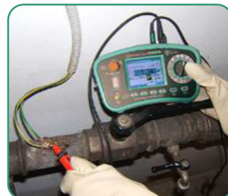
Sprawdzanie połączeń wyrównawczych
